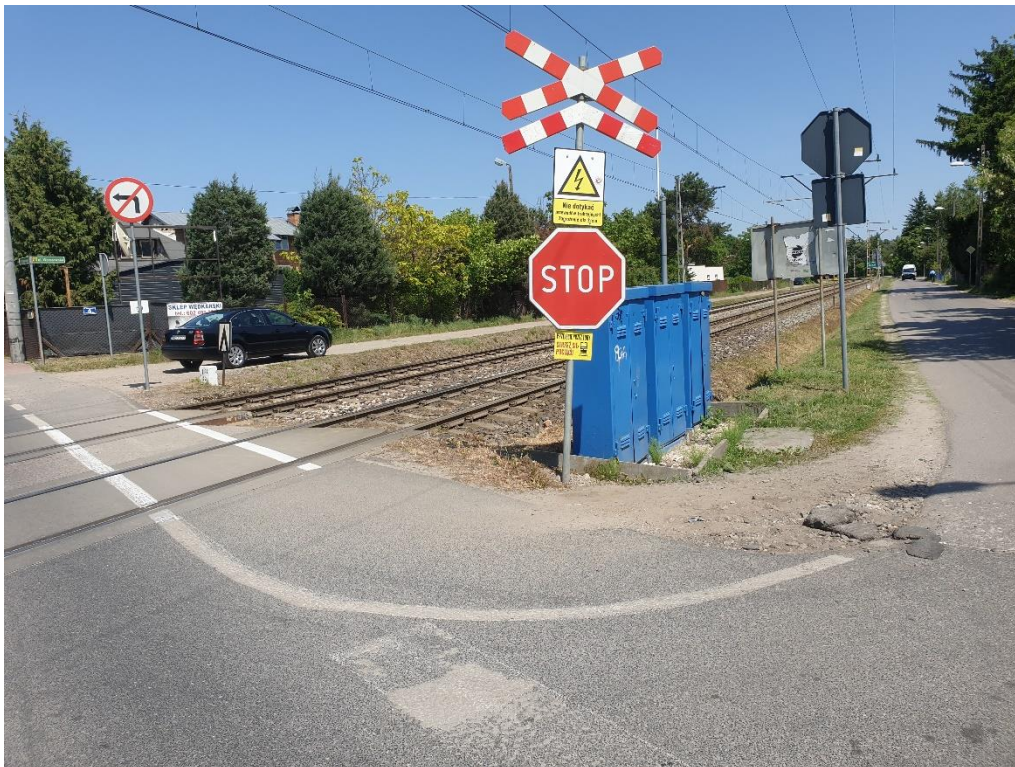
Zdjęcie 4 - Widoczność z 5 m ze strony lewej przejazdu kolejowego w prawo - sytuacja jak w trakcie wypadku (źródło: dokumentacja PKBWK)
