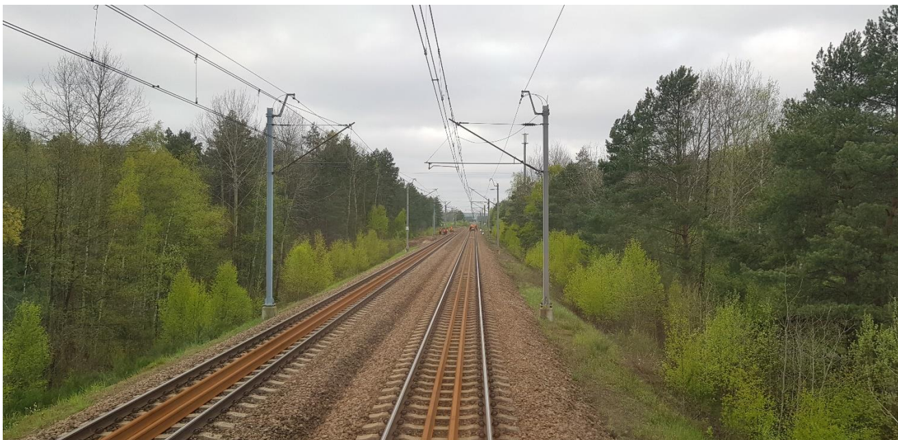
Zdjęcie 1 – źródło: zdjęcie wykonane przez maszynistę poc. 14001.
